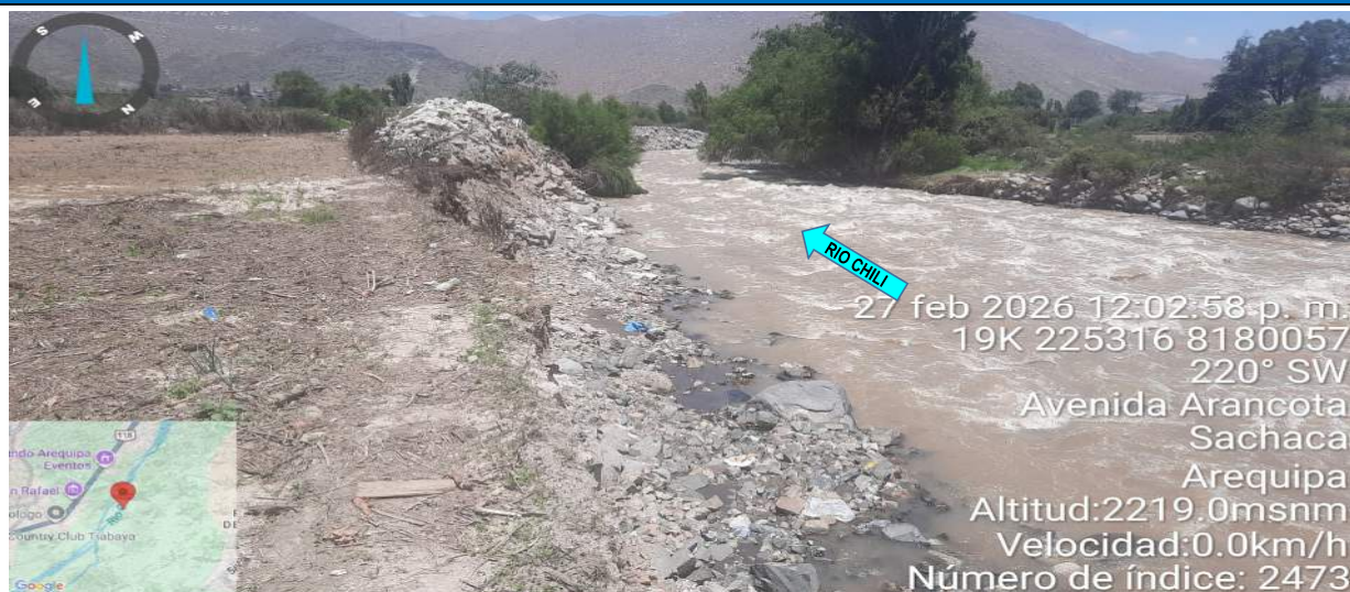
FIGURA N°01: SE MUESTRA AGUAS ABAJO, MARGEN IZQUIERDA DEL RIO CHILI, QUE SE ENCUENTRA SOCAVADO Y COLMATADO CON MATERIAL PROPIO, SIN PROTECCIÓN EN LOS CULTIVOS; Y CON UN INCREMENTO DE CAUDAL DEL RÍO CHILI.
